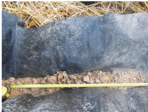
S02 : ensemble du sondage
